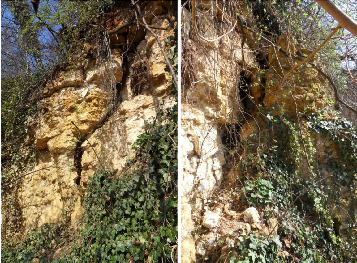
**Photo : 1 Fracture ouverte qui découpe une écaille (3 m de haut) dans la corniche (partie ouest photo de gauche ; partie est photo de droite)**
