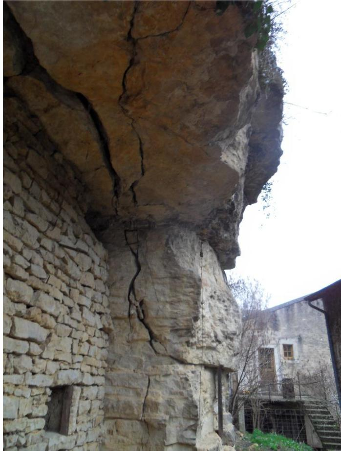
**Photo 2 : Gros plan sur les fractures du sous-cavage de l'entrée de la grotte**
