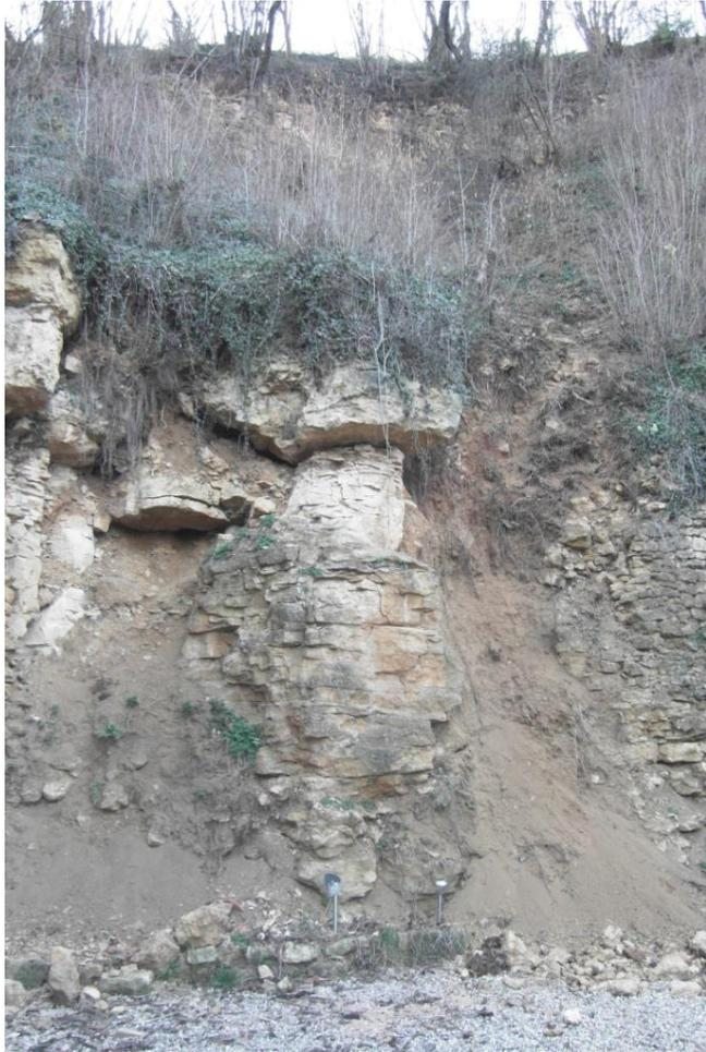
**Photo 2 : Colonne rocheuse instable**
