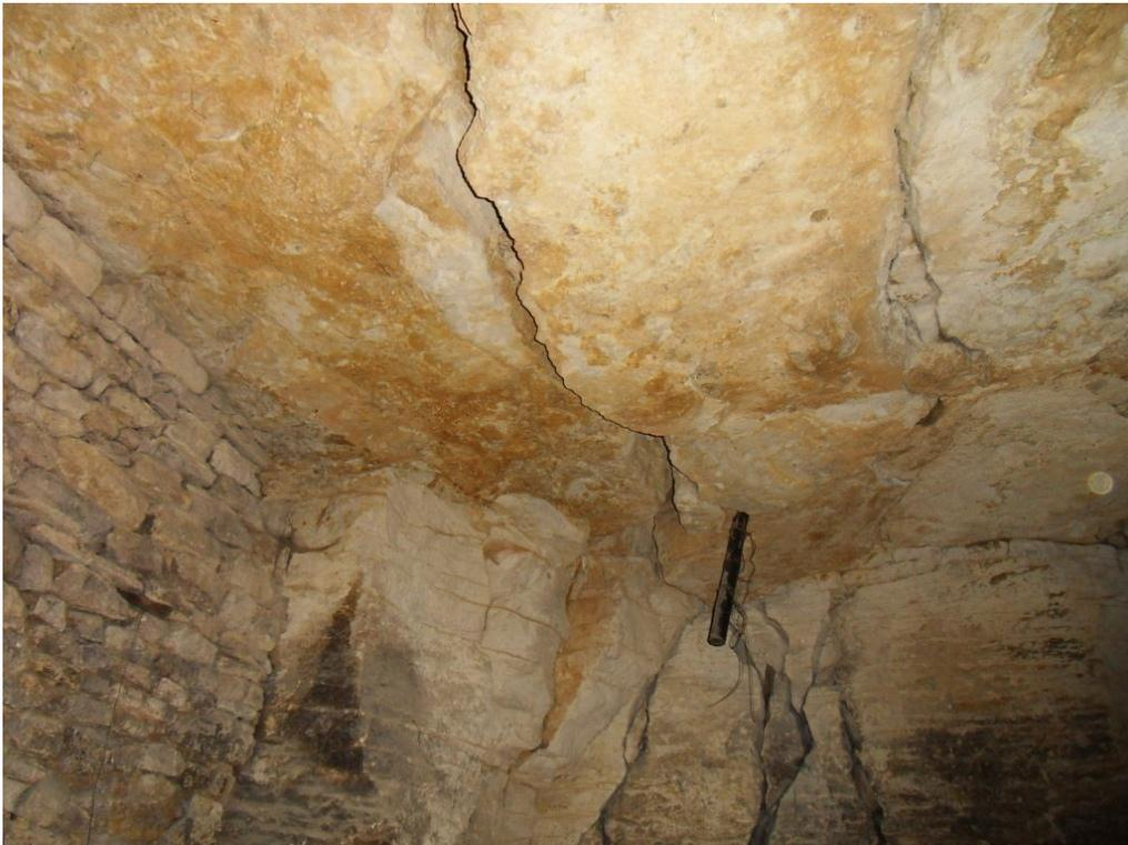
**Photo 3 : Fracture ouverte au fond de la cavité**
