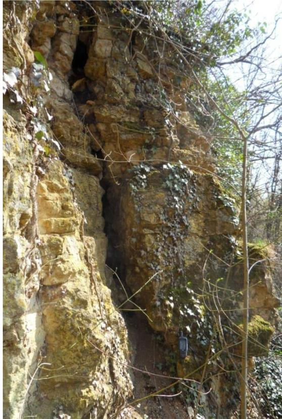
**Photo 1 : Ecaille séparée de la corniche par une fracture ouverte**
